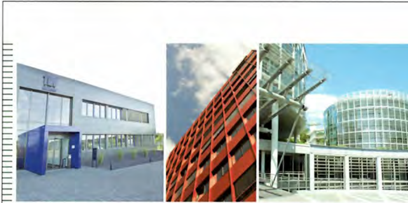
v.l.n.r.: TÜV Saarland, Hattingen | Scheer Tower, Saarbrücken | UKV, Saarbrücken
