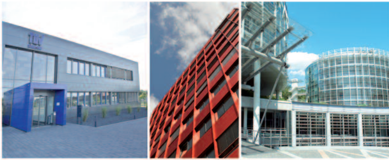
v.l.n.r.: TÜV Saarland, Hattingen | Scheer Tower, Saarbrücken | UKV, Saarbrücken
